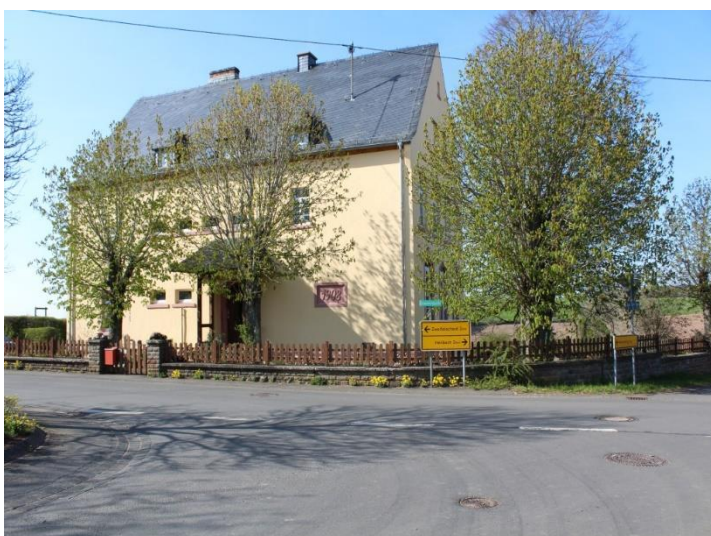
Foto: Renoviertes Schulgebäude
