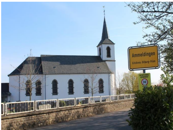
Pfarrkirche St. Isidor (Seitenansicht)
