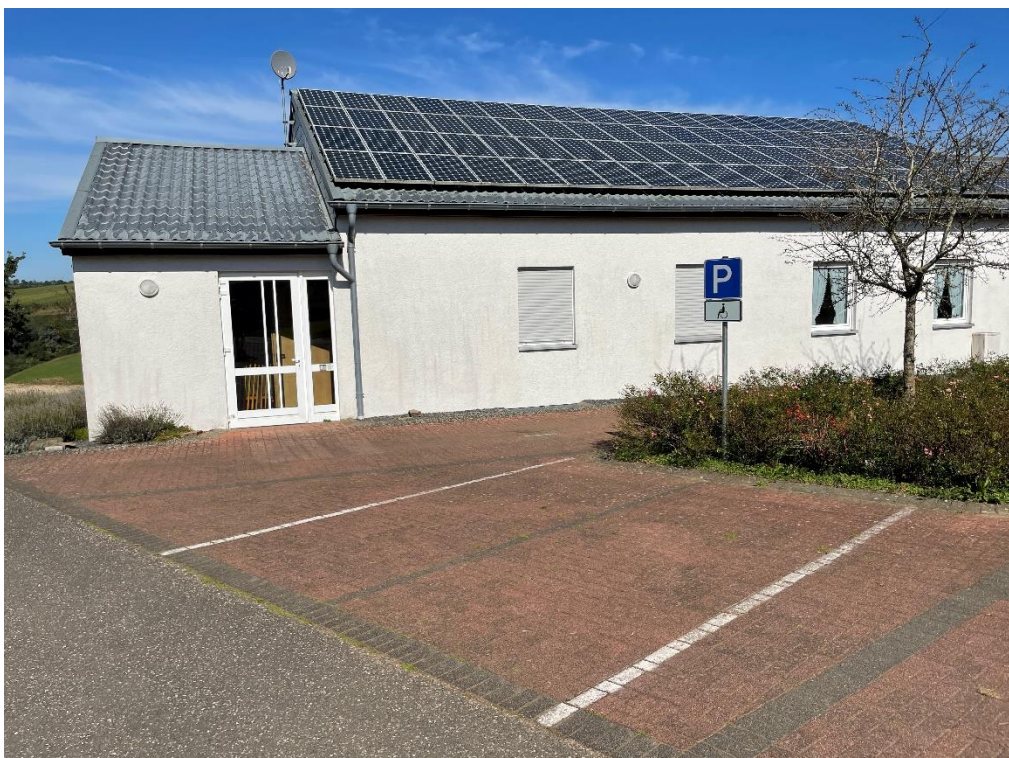
Foto: Zugang Behinderten-WC und Behindertenparkplatz am DGH
